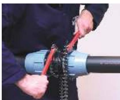
5. Прикрутить обойму сначала вручную и после, используя специальный зажимной ключ. Обойма должна быть закрыта с силой, так как необходимо, чтобы она со-прикасалась с конечной кромкой фитинга.
